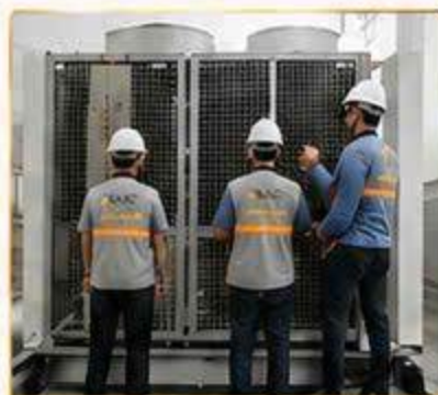
LẮP ĐẶT THIẾT BỊ
