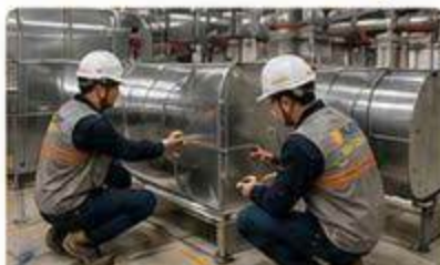
KIỂM TRA CHẤT LƯỢNG THI CÔNG
