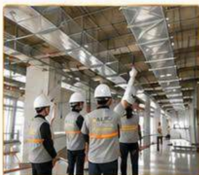
LẮP ĐẶT HỆ THỐNG ỐNG GIÓ
