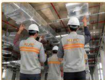
THI CÔNG HỆ THỐNG ỐNG GIÓ
