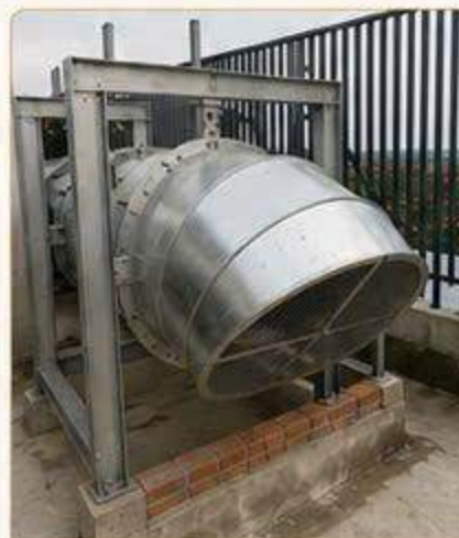
THI CÔNG HỆ THỐNG ỐNG GIÓ
