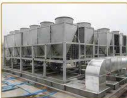
LẮP ĐẶT THIẾT BỊ HVAC
