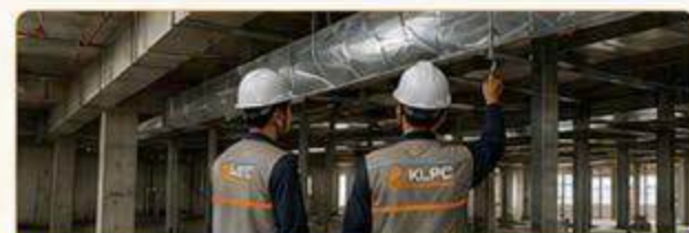
THI CÔNG HỆ THỐNG HVAC
