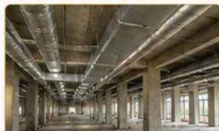
THI CÔNG HỆ THỐNG ỐNG GIÓ
