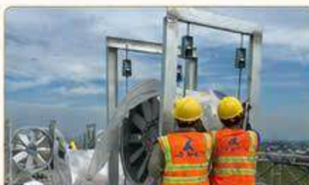
THI CÔNG LẮP ĐẶT QUẠT TRÊN MÁI
