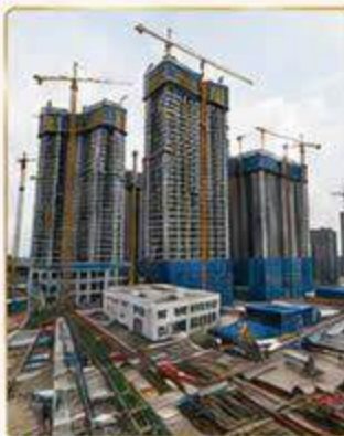
GIẢI ĐOẠN THI CÔNG THỔ
