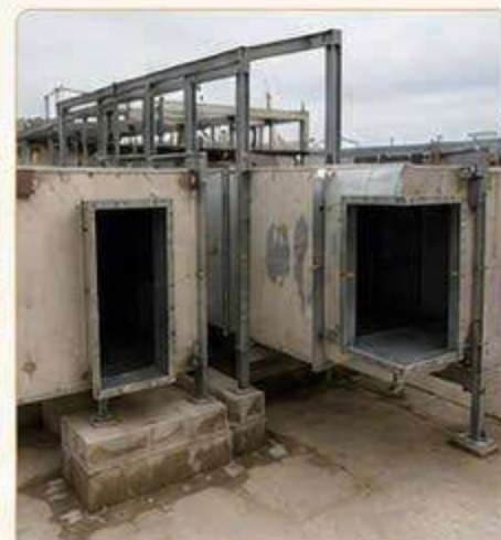
THI CÔNG TẠI HIỆN TRƯỜNG
