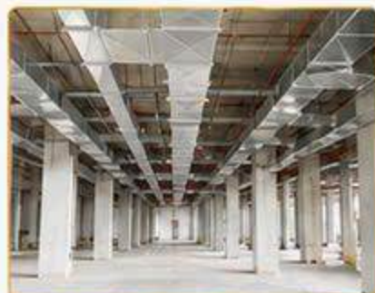
LẮP ĐẶT HỆ THỐNG ỐNG GIÓ
