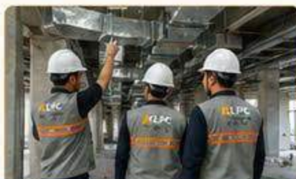
KIỂM TRA & GIÁM SÁT THI CÔNG
