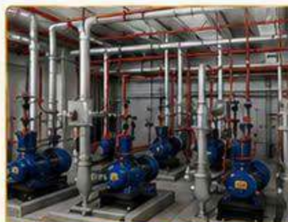
LẮP ĐẶT HỆ THỐNG ỐNG NƯỚC, ỐNG GAS
