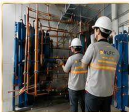
LẮP ĐẶT HỆ THỐNG ỐNG NƯỚC
