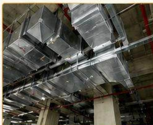
LẮP ĐẶT HỆ THỐNG ỐNG GIÓ
