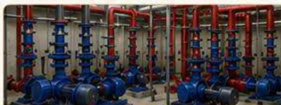
LẮP ĐẶT HỆ THỐNG CƠ ĐIỆN
